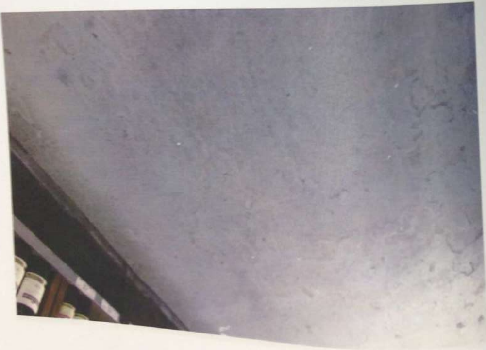
Vista do tipo de piso
