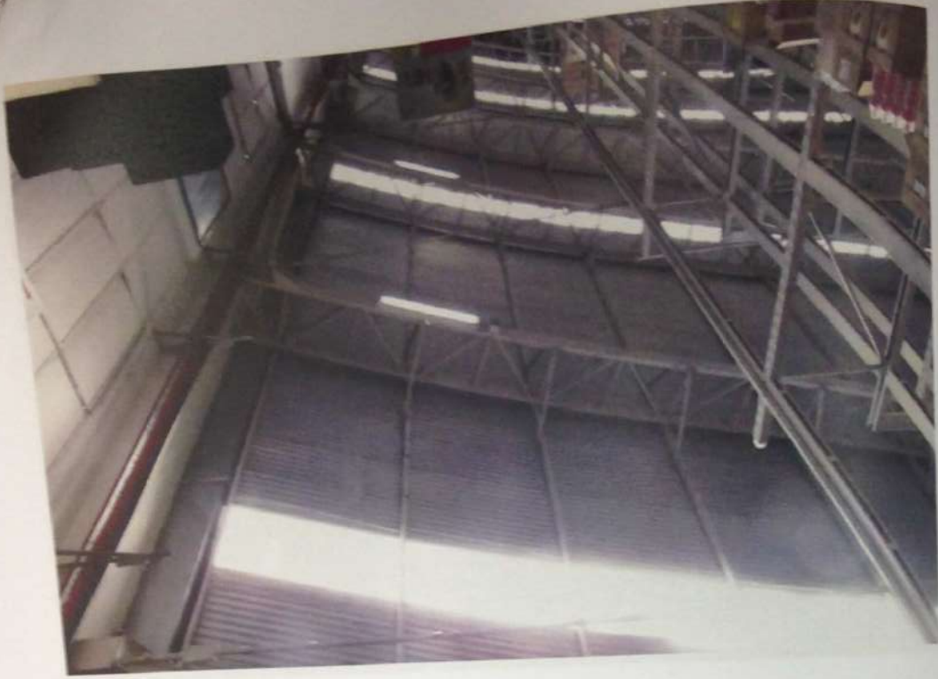
Estrutura da cobertura
