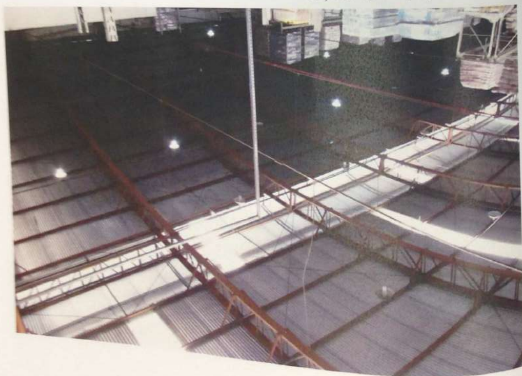
Estrutura e cobertura do depósito
